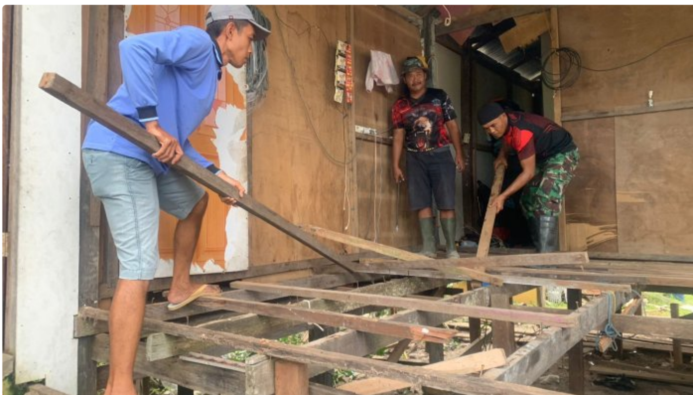
Rehab RTLH UPaya Satgas TMMD Berikan Perlindungan Resiko Sosial
